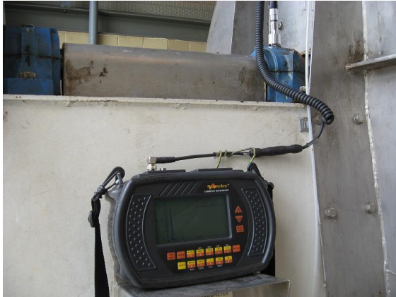
Figuur 19.3 Meting op lager van een ventilator.
