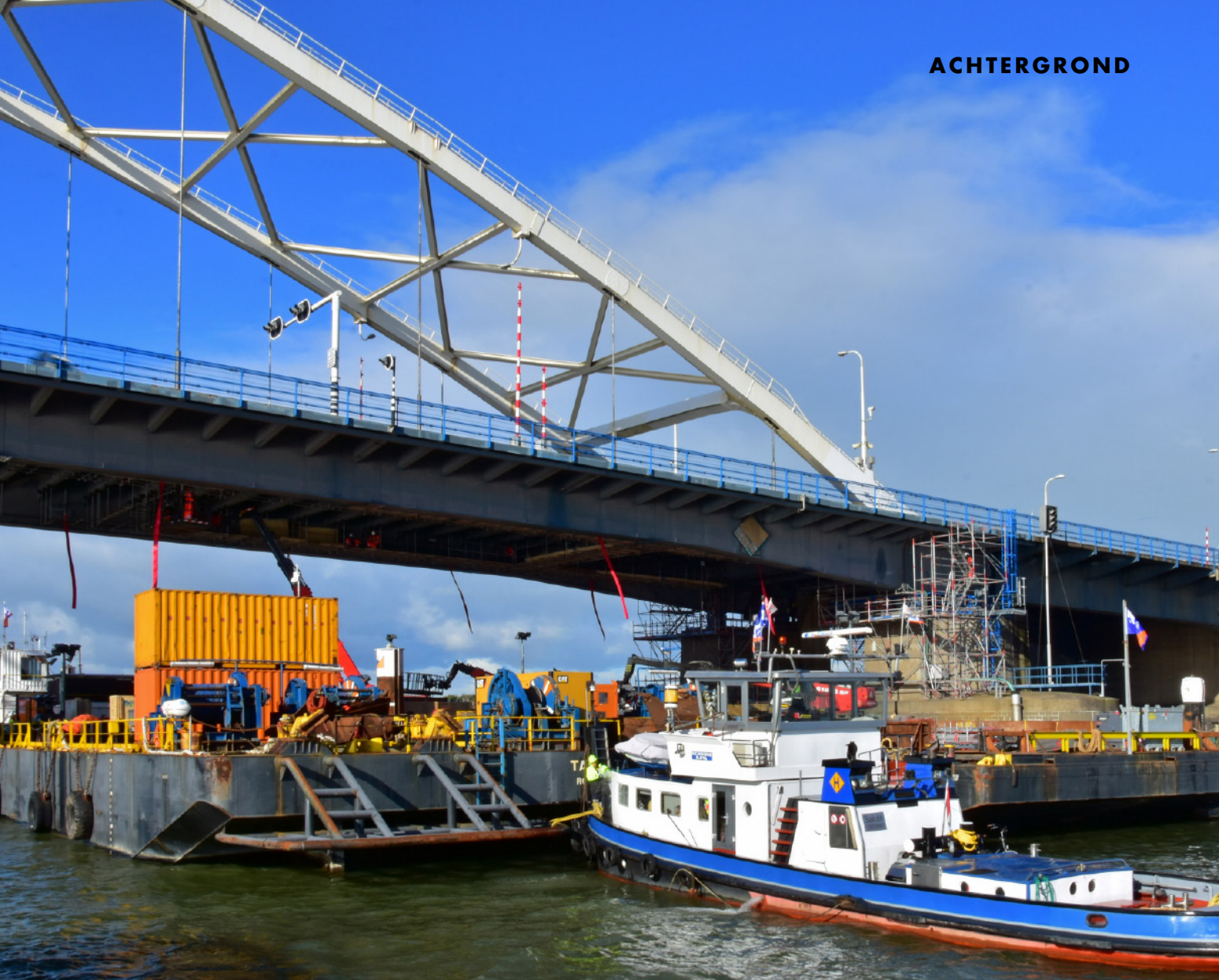
Onderhoud aan de Merwedebrug. Beeld Rijkswaterstaat
