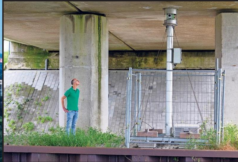
Een spoorviaduct over de Zuidweg in Rijpwetering. Onder het spoorviaduct staat allemaal meetapparatuur om verzakkingen te kunnen meten. FOTO MICHEL VAN BERGEN
