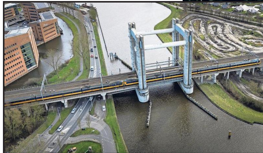
De spoorbrug bij Gouda is notoir storingsgevoelig.
